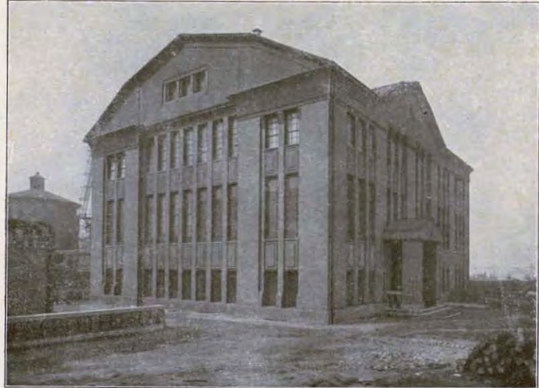
Abb. 65. Außenansicht der elektrischen Zentrale auf Schachtanlage 1/4.
