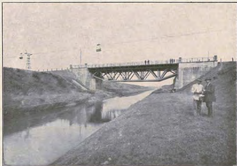
Abb. 87. Die regulierte Emscher mit Brücke zwischen den Schachtanlagen 1/4 u. 2/6.
