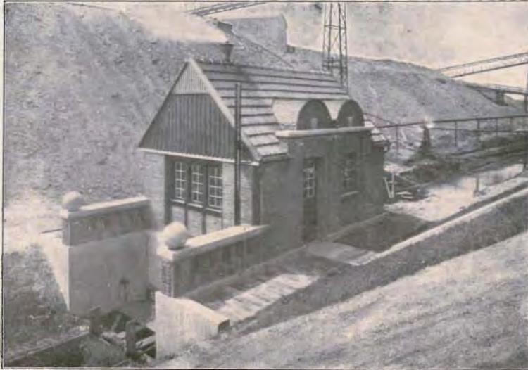
Abb. 86. Polderanlage an der kleinen Emscher bei Schachtanlage 1/4, erbaut i. J. 1916.
