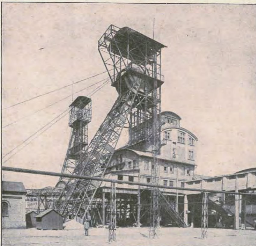
Abb. 78. Die Fördergerüste der Schächte 3/5 mit Verladung und Wäsche.
