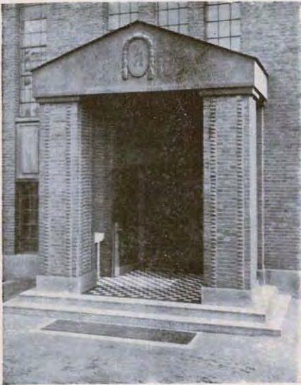
Abb. 64. Eingang zur elektrischen Zentrale auf Schachtanlage 1/4.
