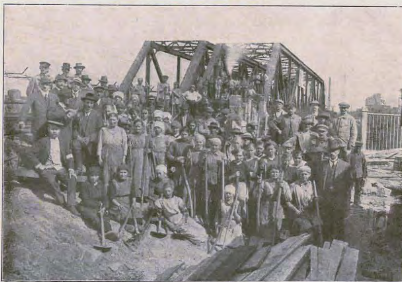
Abb. 122. Kriegsbelegschaft bei Hebung der Kanalbrücke i. J. 1917.
