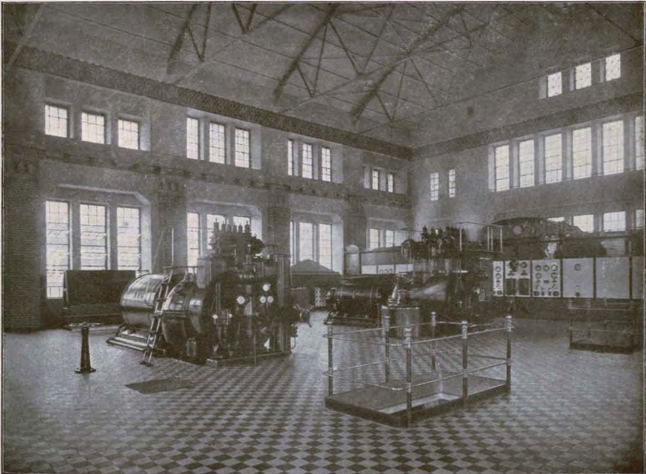
Abb. 66. Elektrische Zentrale der Schachtanlage 1/4 (Innere Teilansicht).
