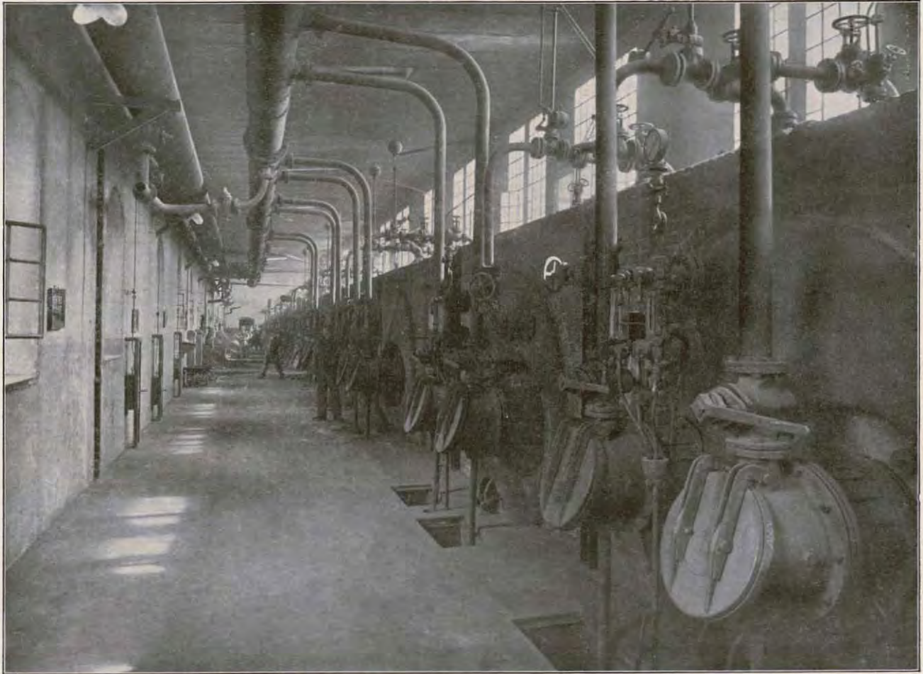
Abb. 55. Kesselhaus des Schachtes 4 (vorn Gaskessel, hinten Stockkessel).
