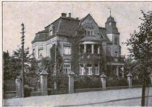
Abb. 121. Direktorwohnung auf Schacht 3/5.
