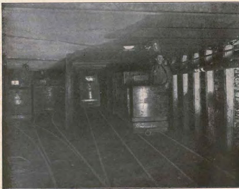
Abb. 40. Benzollokomotivbetrieb unter Tage (links Lokomotiv-Aufstellungsraum) auf Schachanlage 3/5.
