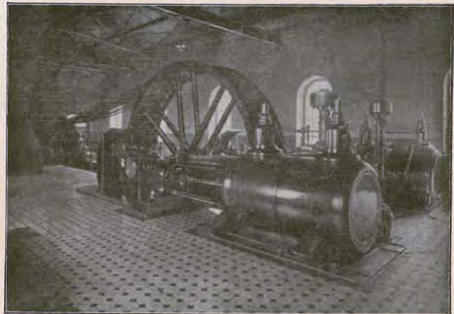
Abb. 50. Ventilator-Antriebsmaschine auf Schachtanlage 1/4.
