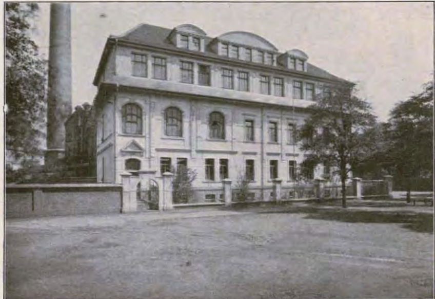
Abb. 15. Das Verwaltungsgebäude i. J. 1917 nach dem Umbau.
